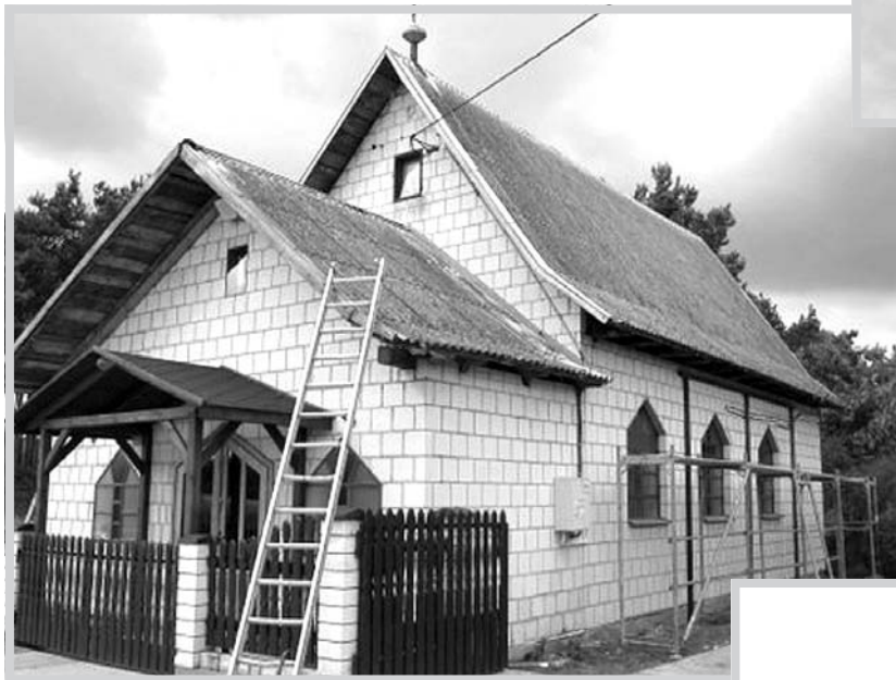
Kaplica przed remontem
